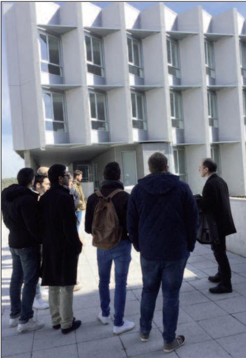
Foto 3: Efecto dentado en el diseño de huecos para reorientar los huecos en fachadas Norte-Este y Sur-Oeste.
